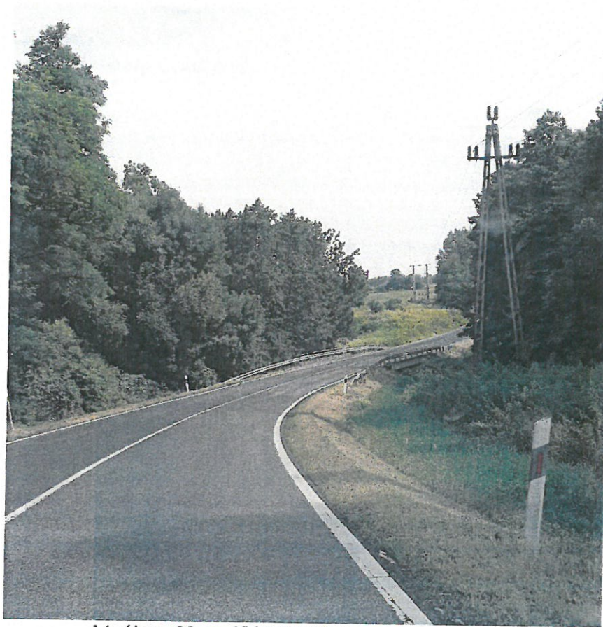
16. ábra: 82. sz. főút 24+243 km szelvénye észak felé
